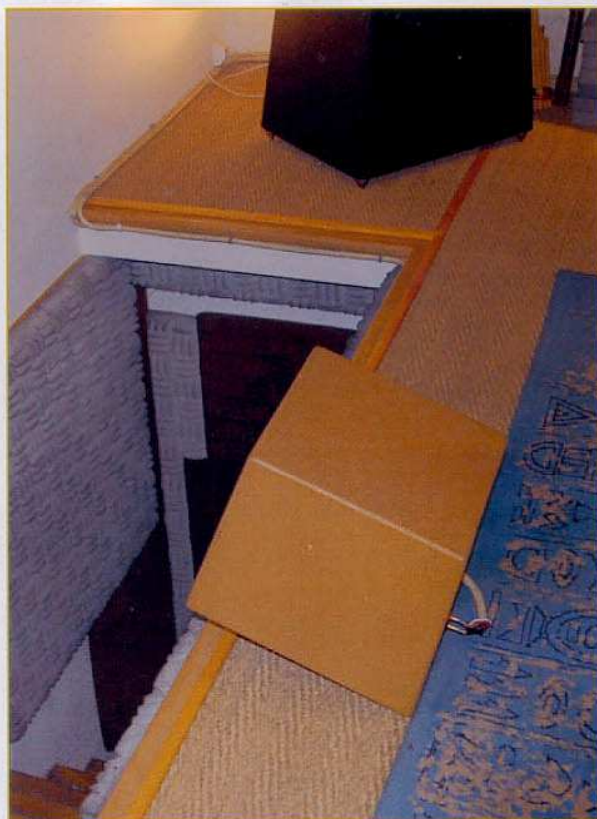
L'escalier d'accès a été traité acoustiquement pour ne pas créer une caisse de résonance indésirable et laisser s'exprimer la voie centrale. Une correction sévère de cette dernière permet d'obtenir des dialogues cohérents avec l'image.
